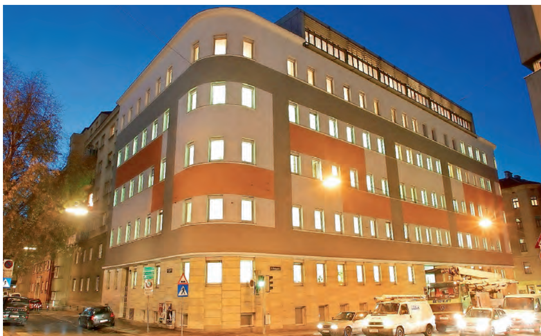
Die BUAK – im Bild der Sitz in der Kliebergasse in Wien – wickelt zahlreiche Arbeitnehmeransprüche überbetrieblich ab.
