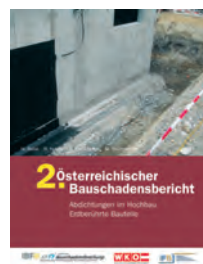
2. Österreichischer Bauschadensbericht, Abdichtungen im Hochbau, erdberührte Bauteile Broschüre
