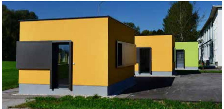
Einer der Themenschwerpunkte des Kompetenzzentrums Bauforschung ist das Forschungsprojekt „Bauteilaktivierung“. Dafür wurden gemeinsam mit der VÖZ und der TU Wien drei Forschungskuben am Gelände der BAUAkademie Salzburg errichtet.
