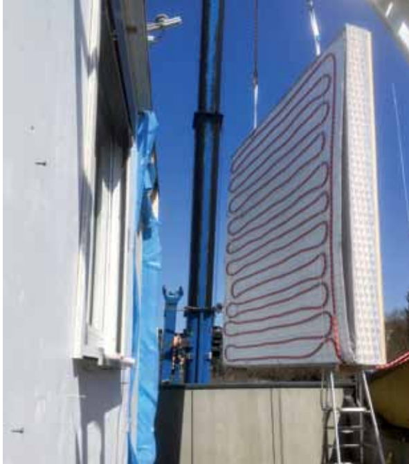
Einbau des Fassadenprototyps aus MultiTab in die Fassadenprüfeinrichtung bei AEE INTEC
