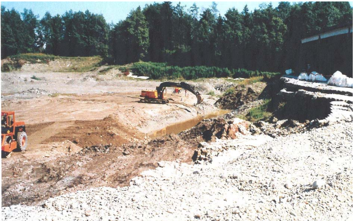
Abb. 1: Sohlgrabarbeiten auf der Altablagerung "Tauschitz-Gründe"
