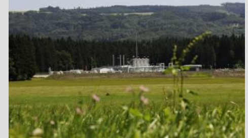
Von RAG betriebene Speicher (Saisonausgleich & Hochleistung)
