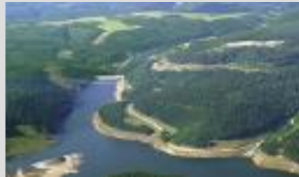
Pumpspeicherwerk Goldisthal (Tagesausgleich)
