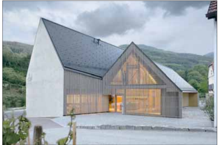
Steile Satteldächer mit minimalem Dachüberstand, handgearbeiteter Außenputz sowie Holzlamellen, die vor Glasflächen des Gebäudes gesetzt wurden, prägen den prämierten Neubau.
