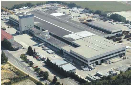
Am Unternehmensstandort in Gars am Kamp konnten die Energiekosten um 50.000 Euro pro Jahr gesenkt werden. Foto: zVg
