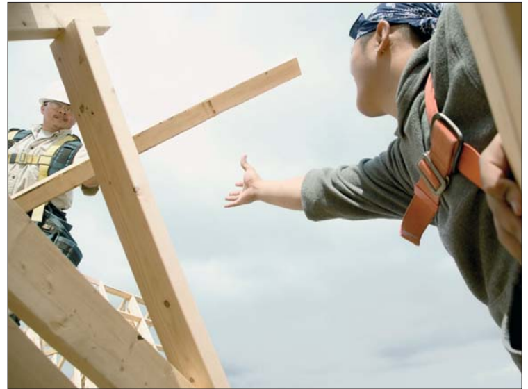
Sicherstellungen sollen das Insolvenzrisiko für Unternehmen im Bau- und Baunebengewerbe vermeiden helfen. Foto: WKÖ
