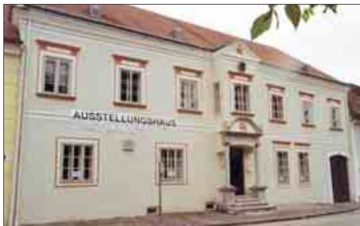
Ausstellungshaus in Hadersdorf/Kamp.
