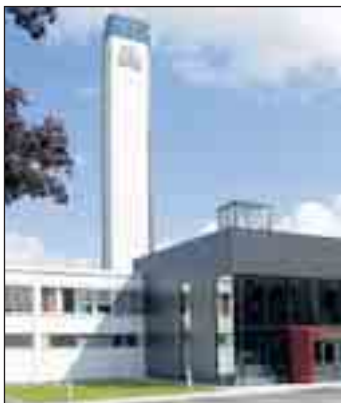
Das 2008/2009 neu erbaute Technologie- und Innovationscenter der Wittur GmbH in Scheibbs mit seinem 50 Meter hohen Aufzugsversuchsturm.
