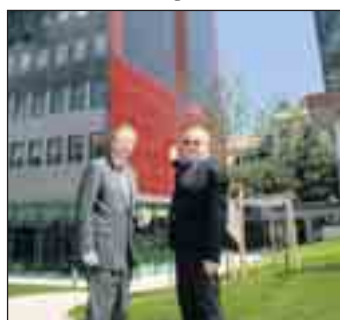
Die „Solarpioniere“ Christoph Leitl und Franz Pacher, Präsident der WKK, vor der Solaranlage der WKÖ.
