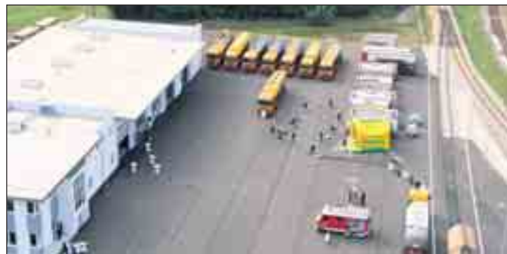
Die neue Betriebsanlage der Schildecker Transport GmbH.
