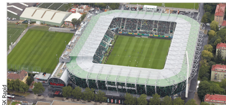
Das neue Allianz-Stadion fasst bis zu 28.600 Besucher.
