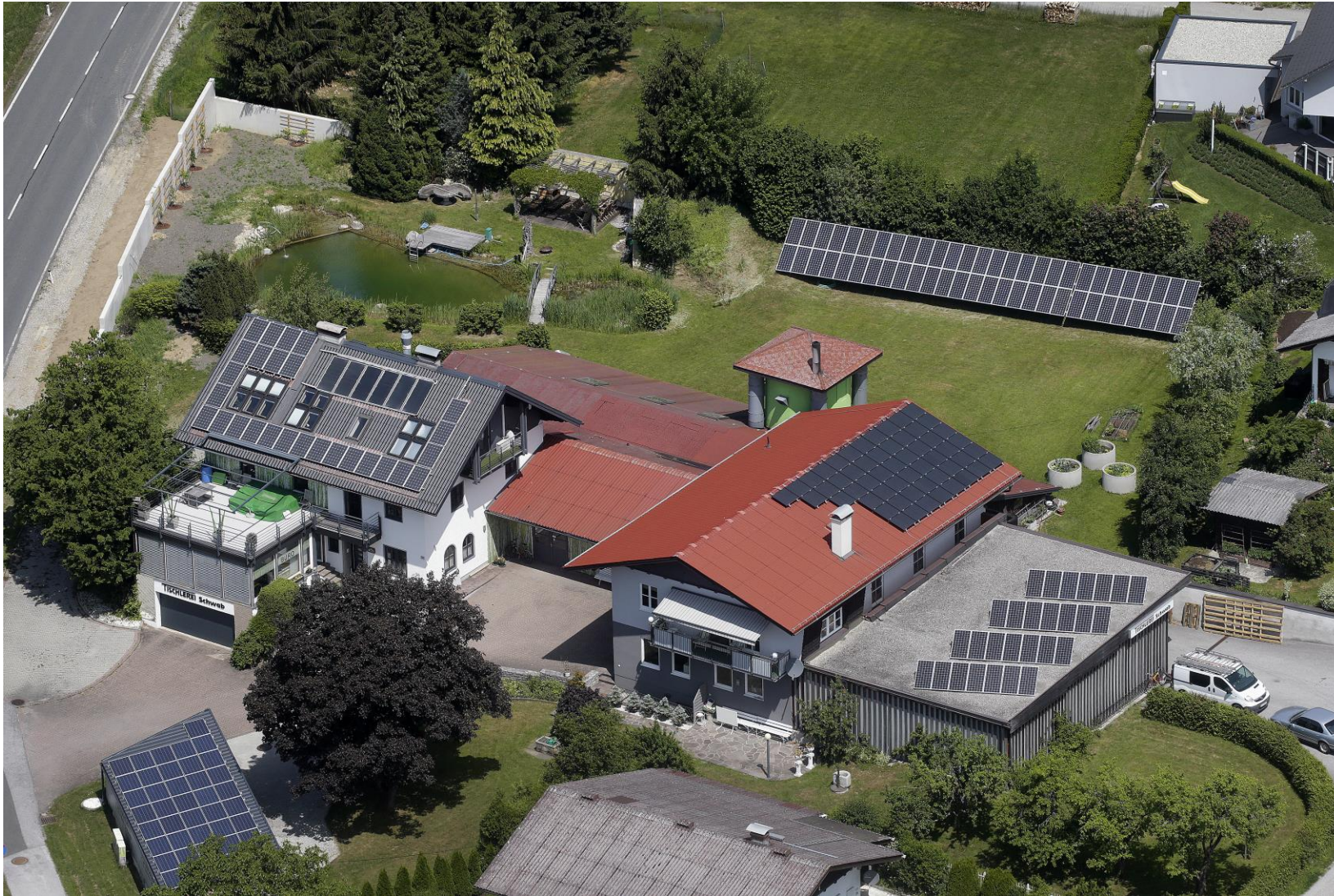
Baustein Ökostromerzeugung: mehrere PV-Anlagen mit 20 kWpeak
